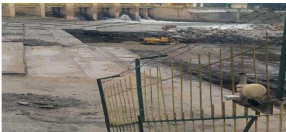
1-расм. Сув ташлаш тўғони 10-11 ораликлари рўпарасида шовва қисмида вужудга келган ёриқлар ва бузилишлар
