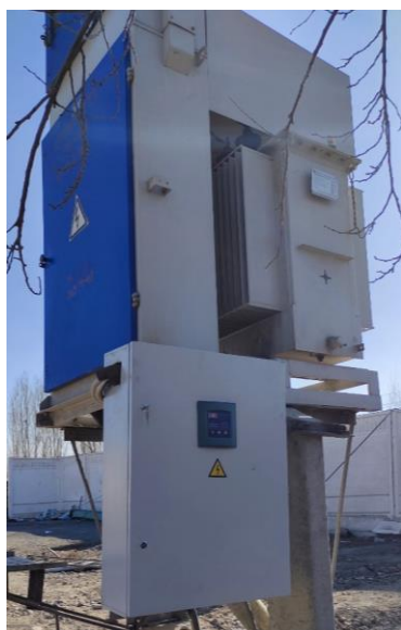
4-rasm. PRF-12 tipli reaktiv quvvatni kompensatsiyalash qurilmasi
