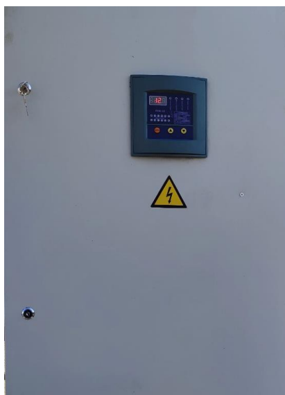
4-rasm. PRF-12 tipli reaktiv quvvatni kompensatsiyalash qurilmasi
