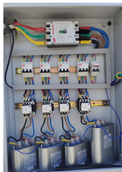
4-rasm. PRF-12 tipli reaktiv quvvatni kompensatsiyalash qurilmasi
