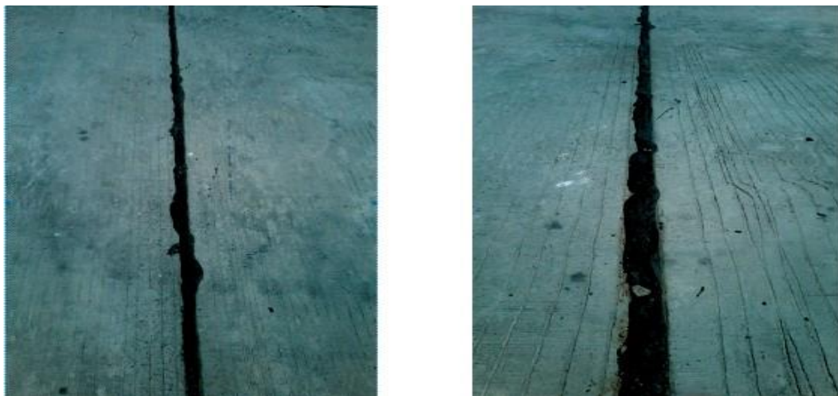
2-rasm: Issiq ob-havoda siqilish choklaridagi mastikaning qoplama yuzasiga chiqib qolishi
