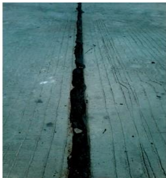
2-rasm: Issiq ob-havoda siqilish choklaridagi mastikaning qoplama yuzasiga chiqib qolishi
