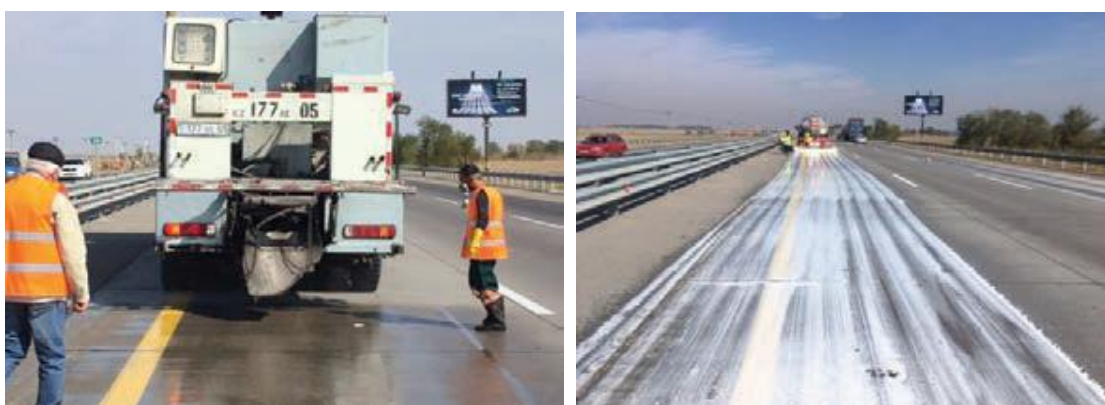
3-rasm: Sementbeton qoplama “STROP-M” texnologiyasini qo‘llash jarayoni
