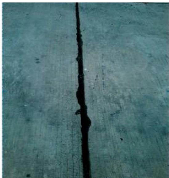
2-rasm: Issiq ob-havoda siqilish choklaridagi mastikaning qoplama yuzasiga chiqib qolishi
