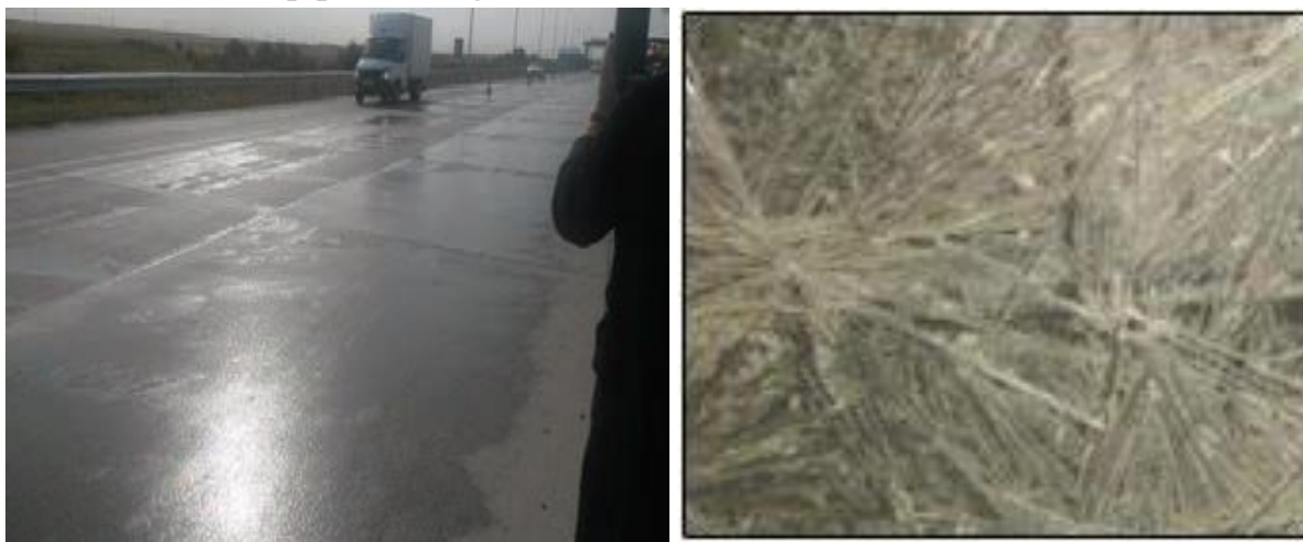
4-rasm: Sementbeton qoplamada “PAVIX CCC100” texnologiyasini qo‘llash jarayoni
