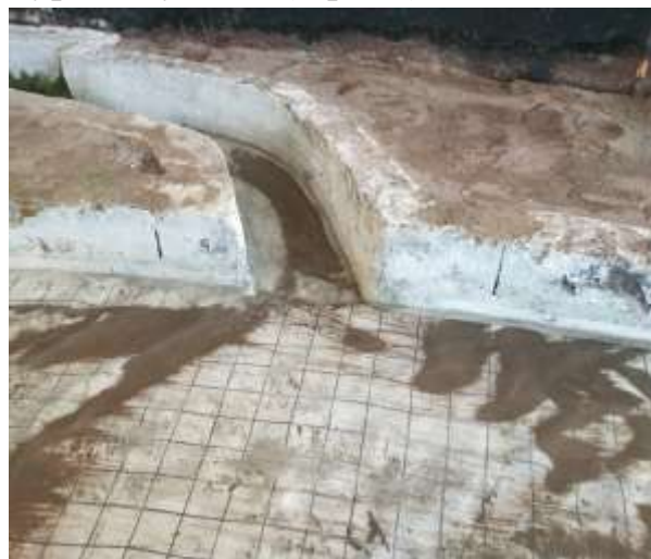
Вақт ўтиши билан тўғонсиз сув олиш иншоотидаги чўкманинг тўпланиши
